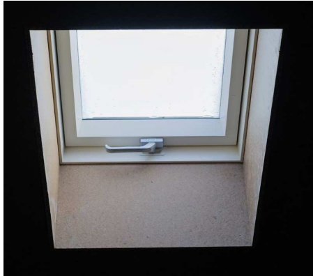
Voorbeeld van een dakvenster t.b.v. ventilatie
