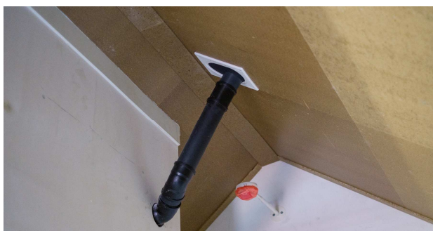
Voorbeeld van een dakdoorvoer-inpandig
