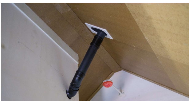
Voorbeeld van een dakdoorvoer-inpandig
